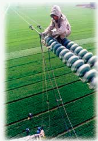
图 1-38 高压带电作业
