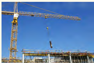
图 4-2-2 塔式起重机搬运建材
