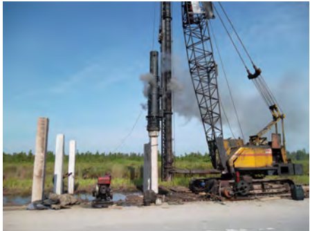
图 4-7-1 落锤打桩机
