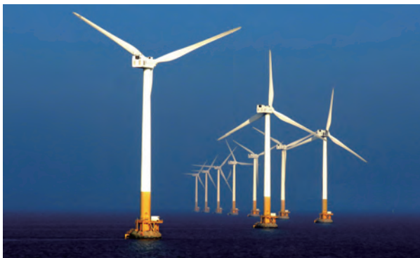
图 12-3 上海市东海大桥 10 万千瓦风电场
