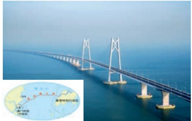
跨海桥隧：港珠澳大桥跨越伶仃洋，东接香港，西接珠海和澳门，总长约55千米，是迄今世界上最长的跨海大桥。港珠澳大桥集桥、岛、隧于一体，其中海底隧道约6.7千米。通车后，从香港到珠海的驾车时间由3个多小时缩减为半个多小时。
