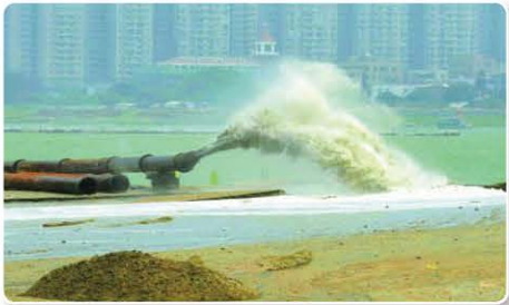
马銮湾4号生态岛吹填现场
