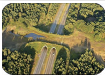
京新高速公路上的动物通道
