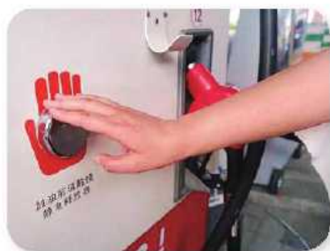
在加油站安装除静电装置
