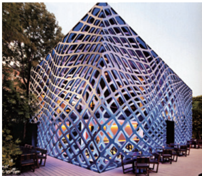
花苞餐厅 外观流动性的网状结构，用玻璃和数控切割双层钢板接合制成，好像植被从地面蜿蜒生长着爬上屋顶。
