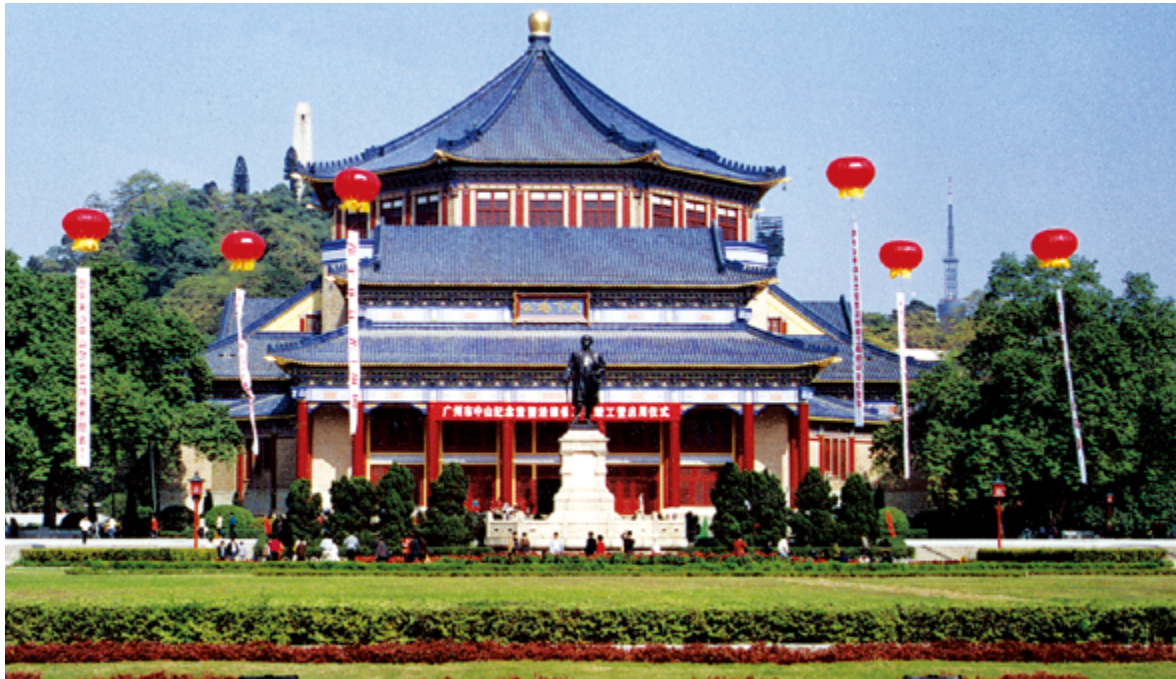
广州中山纪念堂 （建筑） 1929—1931 吕彦直 广州中山纪念堂是我国近现代建筑史上的代表作。其平面造型呈八角形，礼堂居中，为单檐八角攒尖顶，整座建筑外观以蓝色琉璃瓦屋顶、红色柱廊和窗饰形成鲜明的对比，华丽而庄重。 设计师吕彦直运用了现代的结构设计方法，解决了我国古建筑大跨度空间结构的难题。
