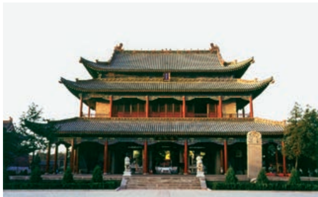
山西临汾尧庙
