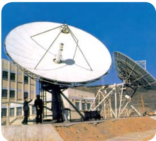
图17-4-3 碟形天线用来接收来自卫星的信号
