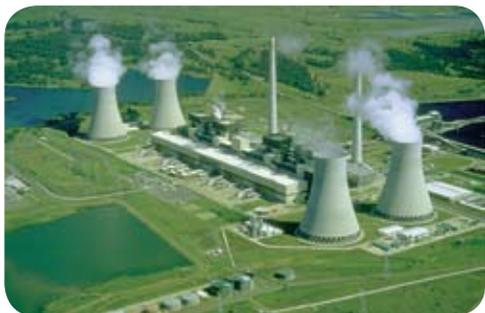
图14-1-1 火力发电厂把燃料的化学能转化成电能
